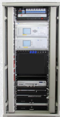
漏洞挖掘平台
