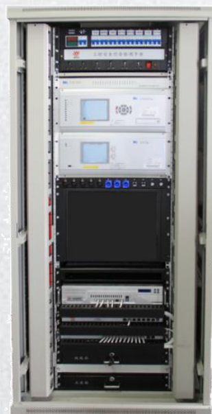
漏洞挖掘平台
